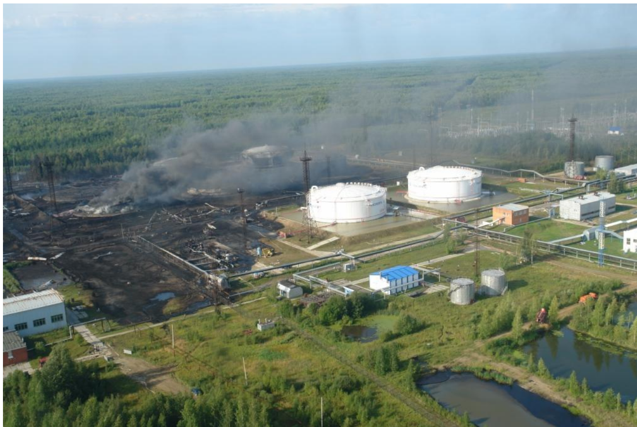
Рисунок 1.2 – Пожар в резервуарном парке линейной производственно-диспетчерской станции (ЛПДС) «Конда»
