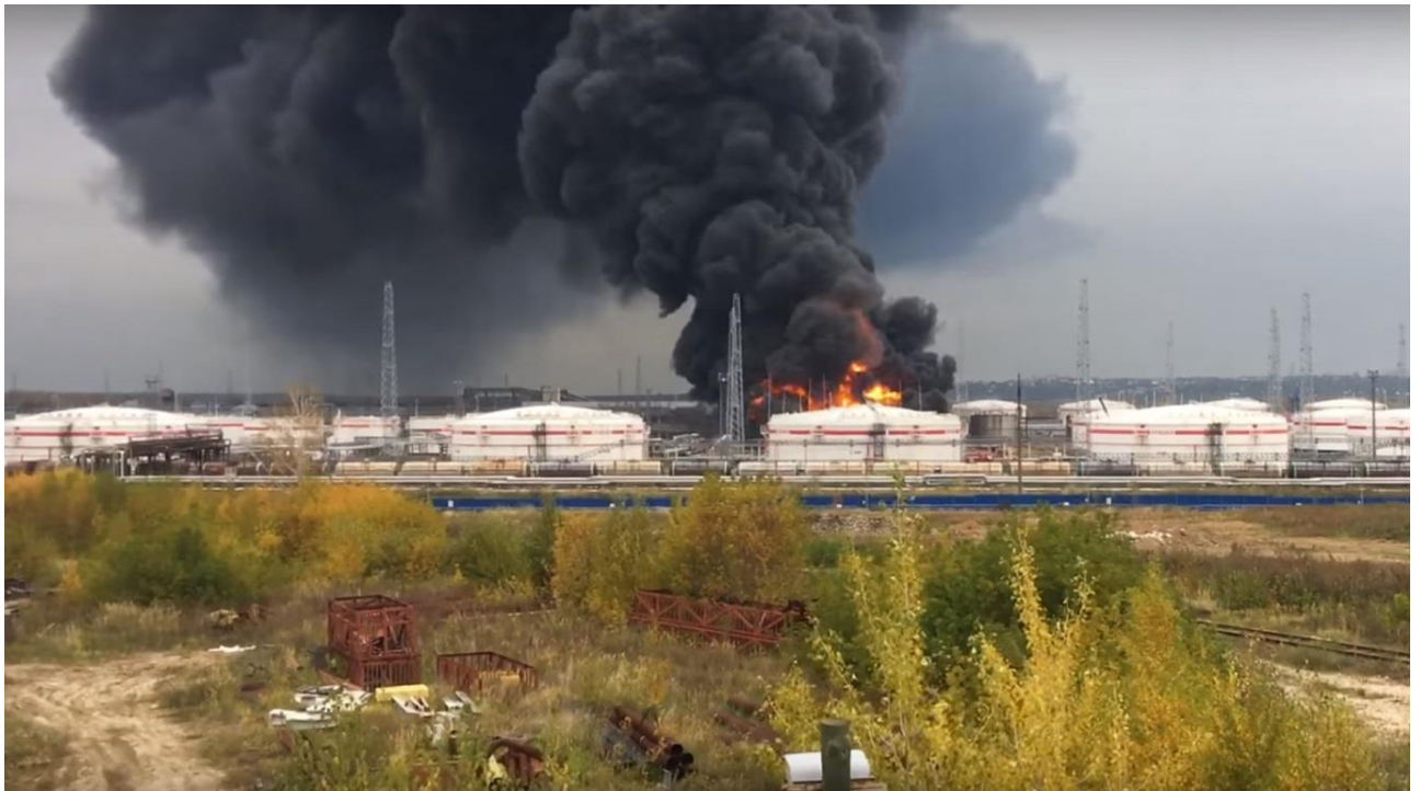
Рисунок 1.7 – Пожар на нефтеперерабатывающем заводе «Лукойл» в Нижегородской области
